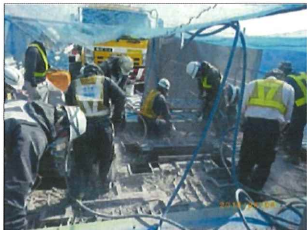
2. 伸縮装置の撤去
