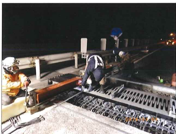
3. 伸縮装置の設置
