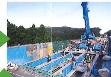
古い床版撤去状況
