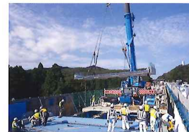
新しい床版設置状況
