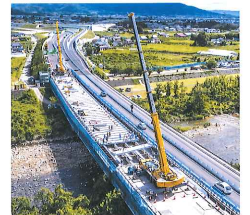
工事実施状況
